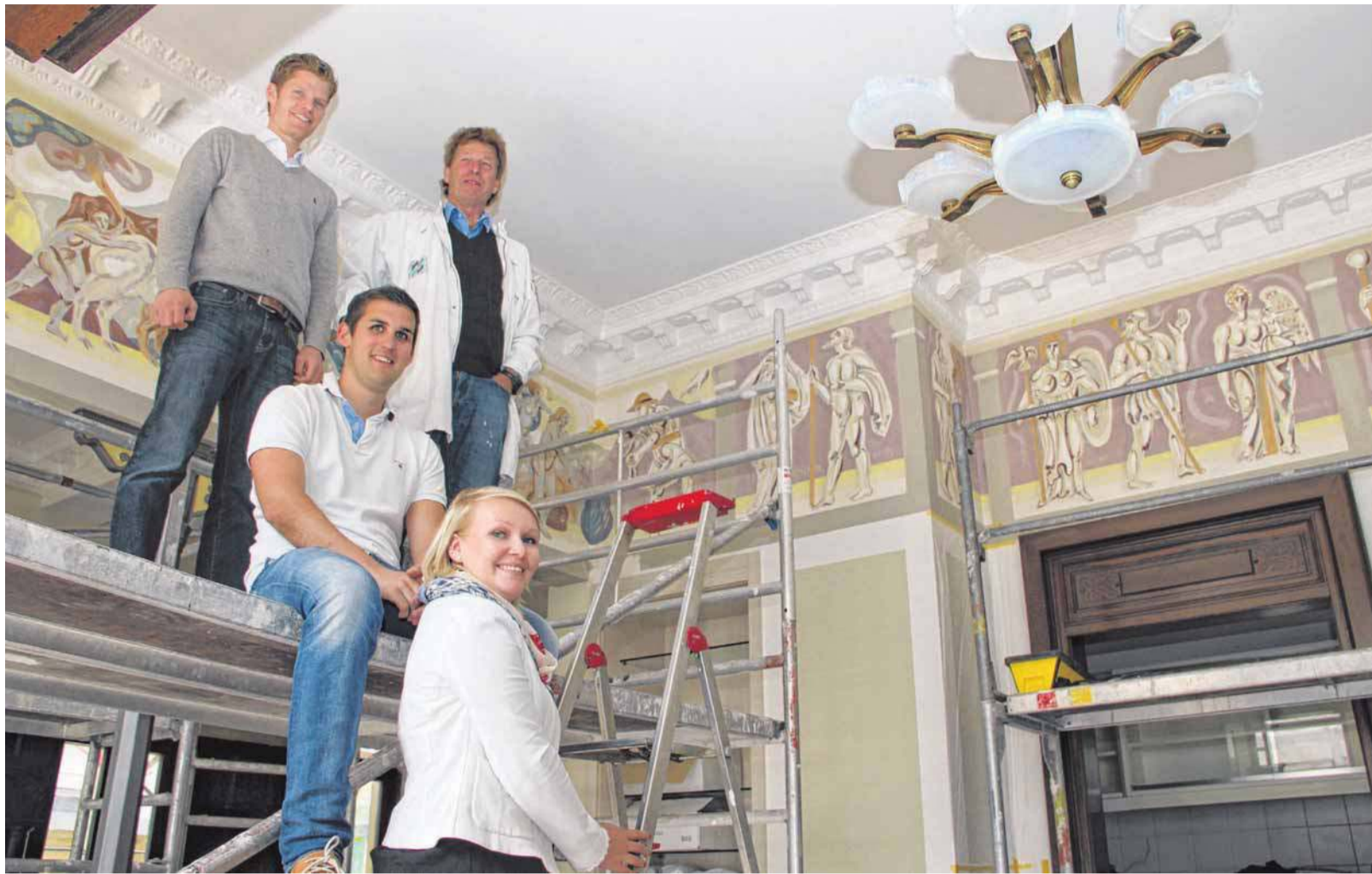
Die Renovierung des „Hermes“ läuft auf Hochtouren. Auf die Eröffnung im September freuen sich die Eigentümer Claus und Christian Striebel (oben rechts und links) und die Pächter Nico Siepmann und Elisa Frank.
